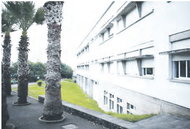
FOTO: ESCOLA SECUNDARIA DE LAGOA/GOOGLE MAPS
