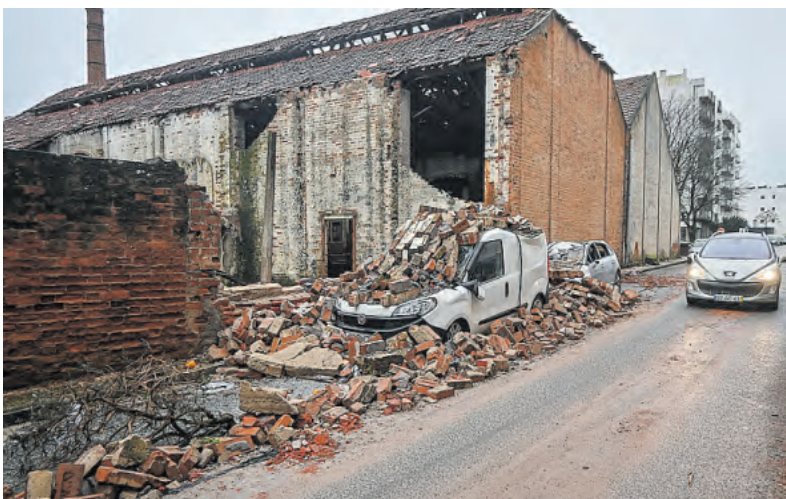
Marinha Grande. Cinco dias após a passagem da tempestade 'Kristin', um carro permanecia soterrado nos escombros.
