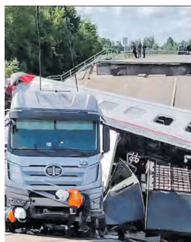
Ponte desaba em linha férrea
