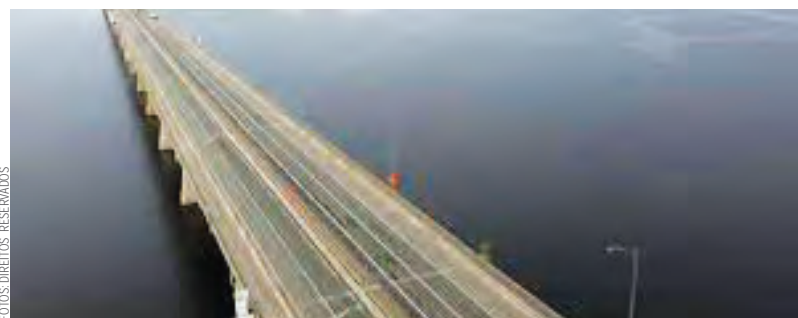
A ponte é a principal via de acesso ocidental à ilha de Montreal
