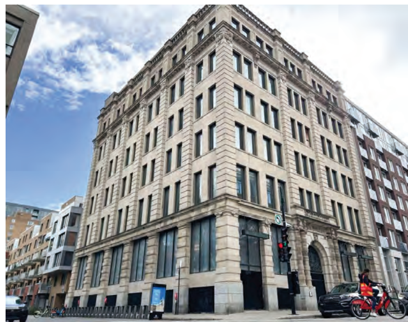
Existem cerca de 800 edifícios abandonados em Montreal
